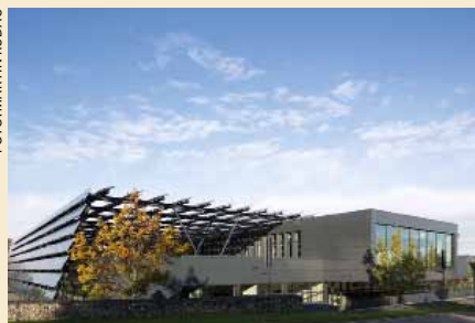
Elobau Erweiterung Werk 2, Leutkirch Eingereicht von: Dr.-Ing. Robert Himmler, EGS-plan International GmbH Bauherr: Elobau GmbH & Co. KG Architekt: HHS Planer + Architekten AG TGA-Planer: EGS-plan GmbH
