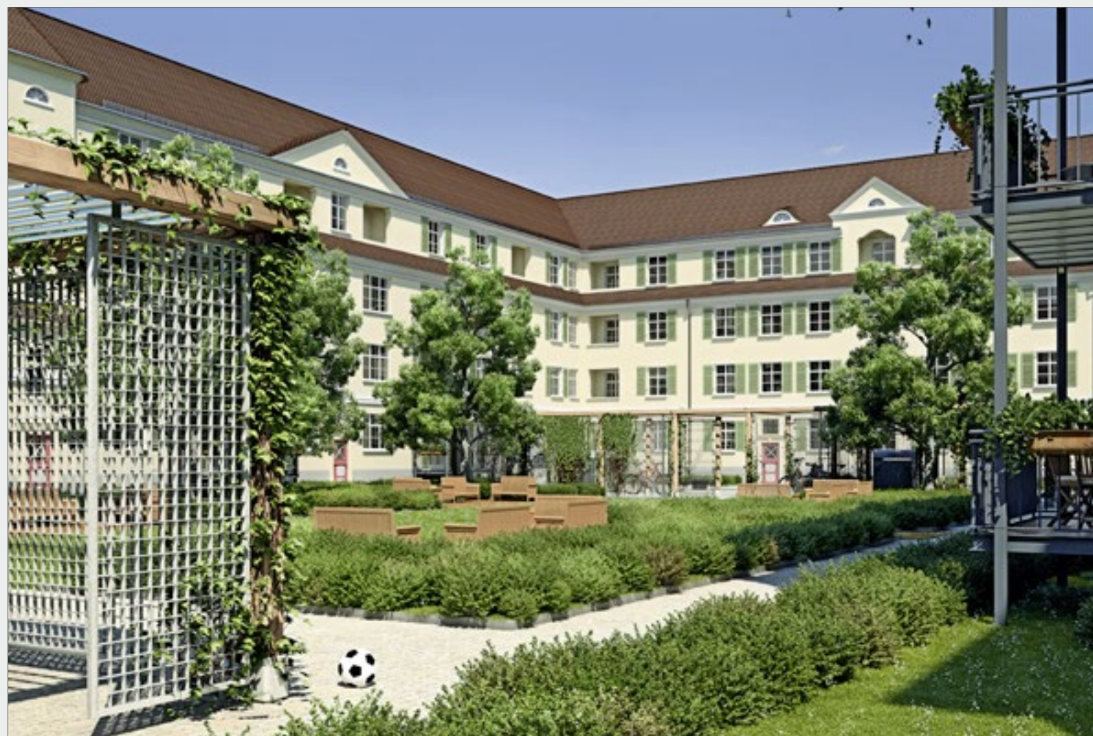
Innenhof nach der Sanierung
