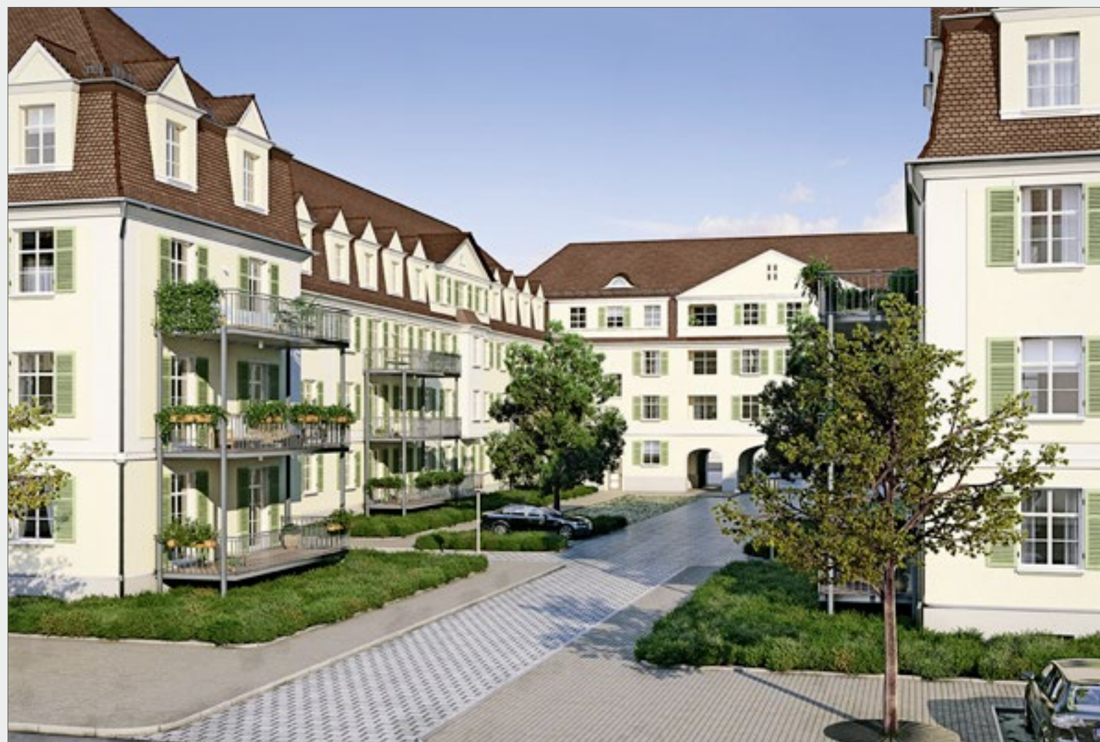
Innenansicht nach der Sanierung
