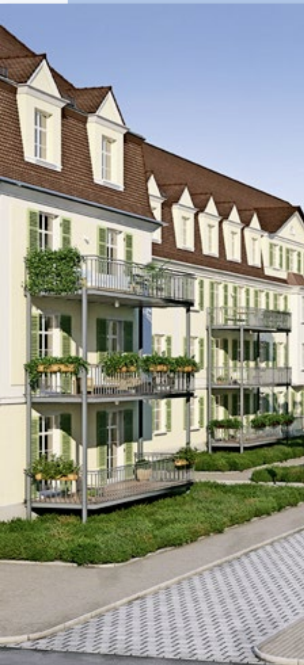
Innenhof nach der Sanierung
