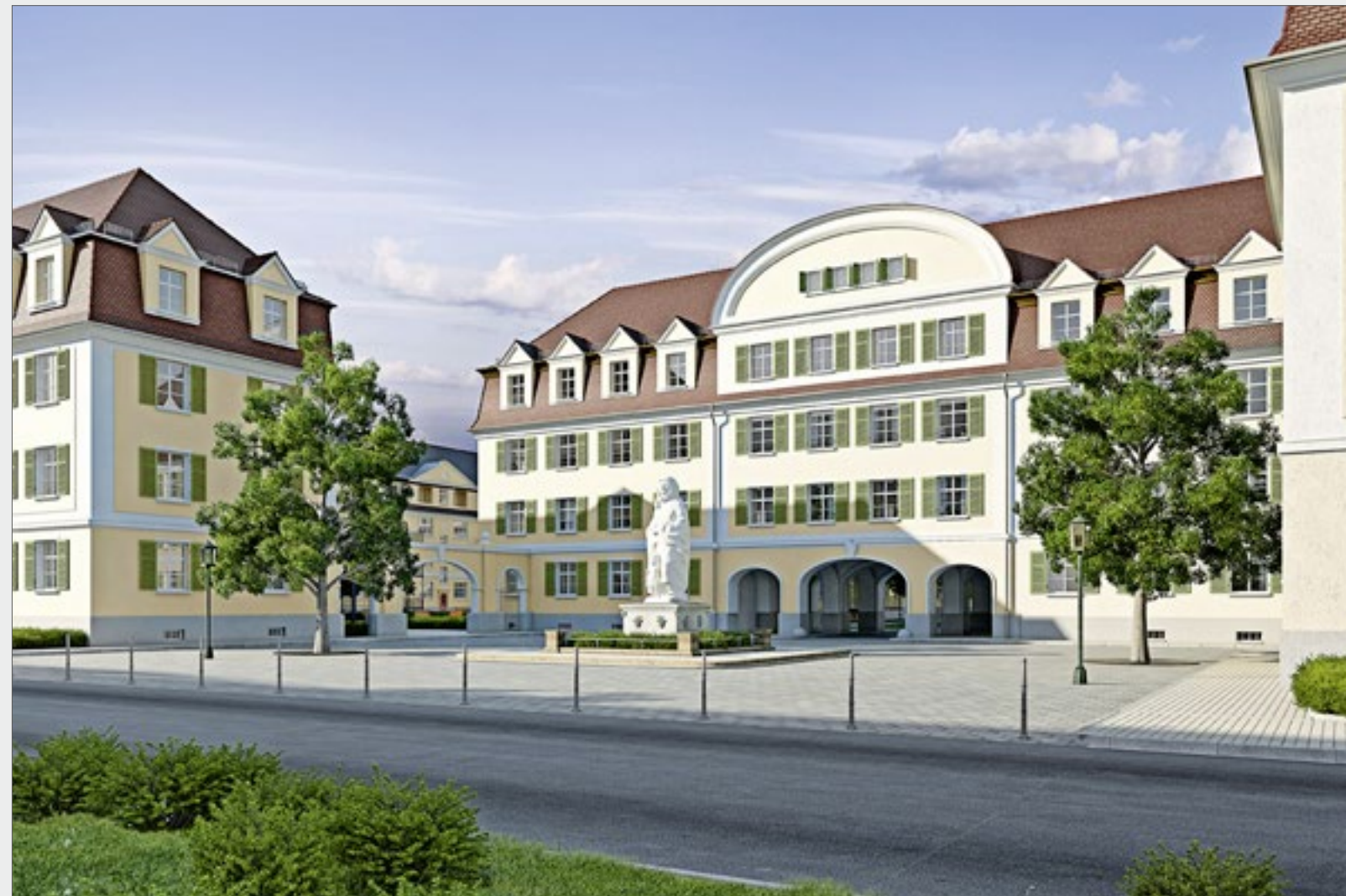
Straßenansicht nach der Sanierung
